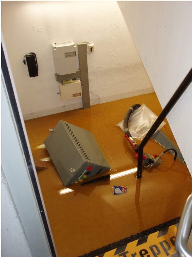
Abb. 1: Eine Fehlfunktion der Abwasserpumpenanlage führt am 09. Mai 2013, einem Feiertag, dazu, dass der Betriebsraum der Aufzugsanlage komplett unter Wasser stand.
