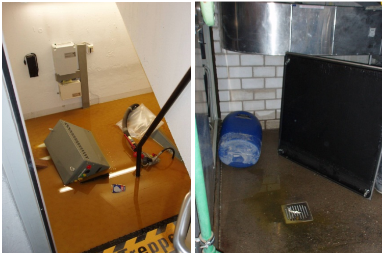
Abb. 3.1: Überschwemmter Betriebsraum Lift (links) und feuchter Betriebsraum Klima (rechts).
