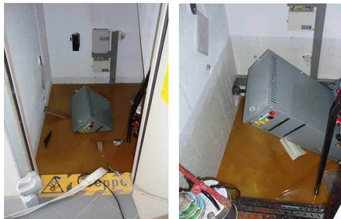
Abb. 3.3: Fortschritt der Abpumparbeiten.
