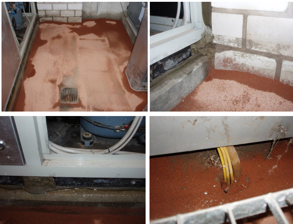
Abb. 3.5: Wasserränder im Betriebsraum Klima.
