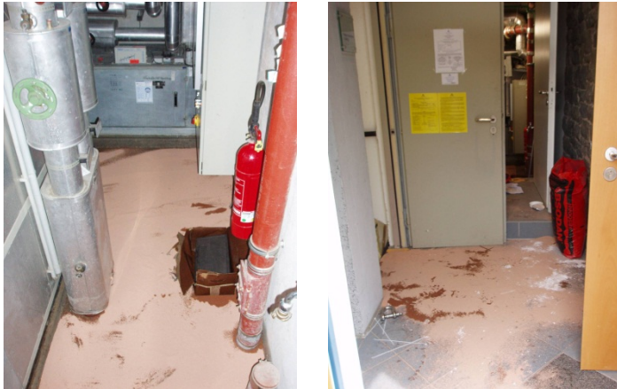
Abb. 3.4: Bindemittel im Betriebsraum Klima (links) und im Hausflur (rechts).
